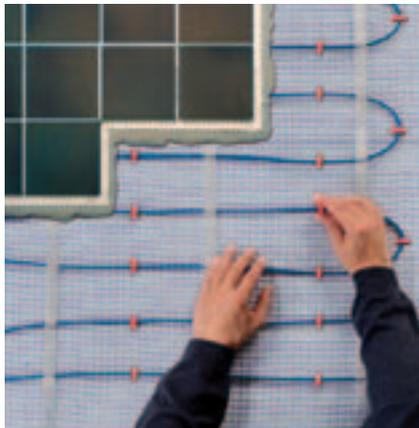
T2Blue en Trame est une trame chauffante de 5 mm d'épaisseur, à poser dans le mortier de scellement ou la chape.
