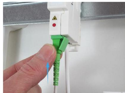
Pour faire les mesures de contrôle ou pour raccorder un appareil au réseau optique, brancher un cordon optique sur une sortie.
