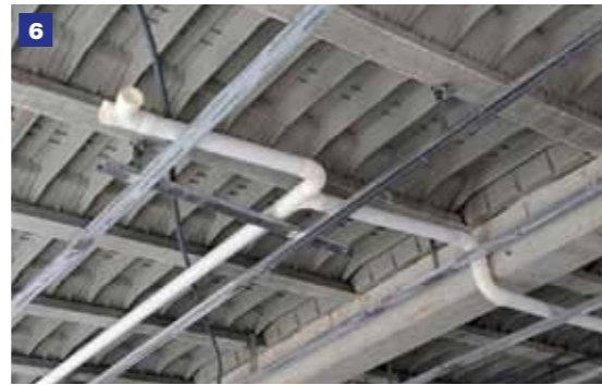
Montage en faux plafond
